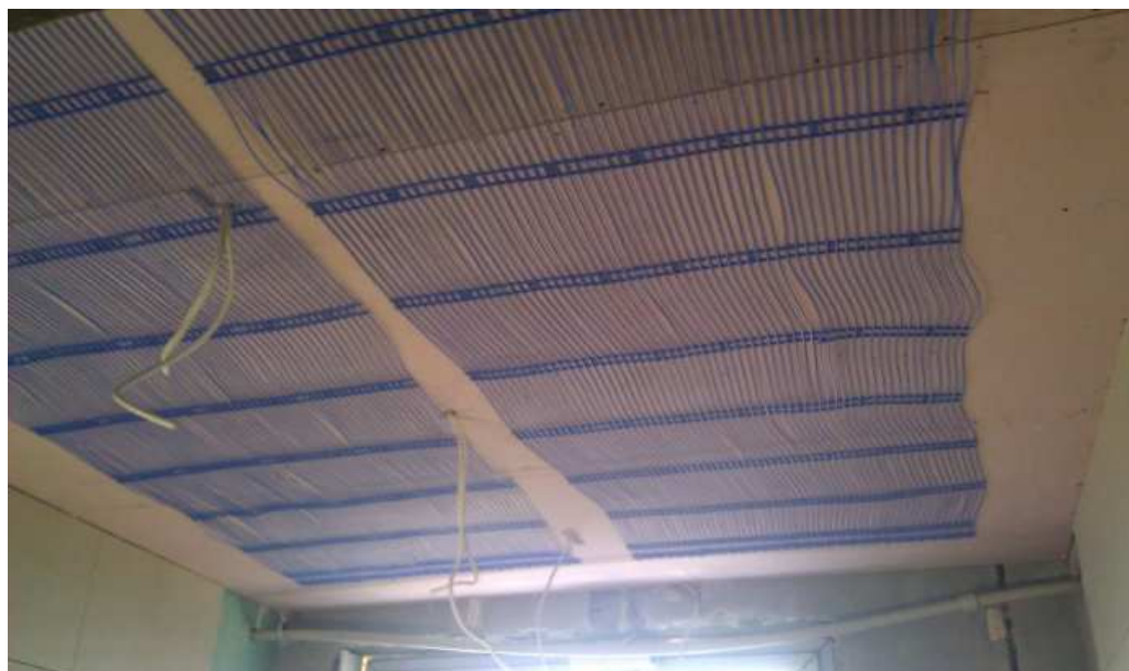
montaż mat pod sufitem podwieszanym
